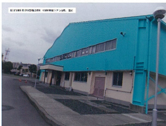
平成23年3月撮影（塗装直後）
