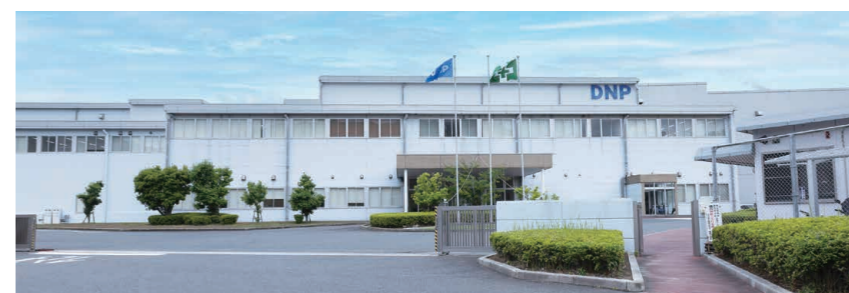
黒崎工場(福岡県)の外観
