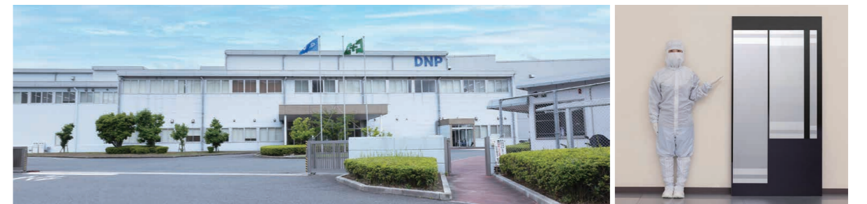
黒崎工場(福岡県)の外観
