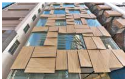
「アートテック®」施工事例 (建物の外装)
