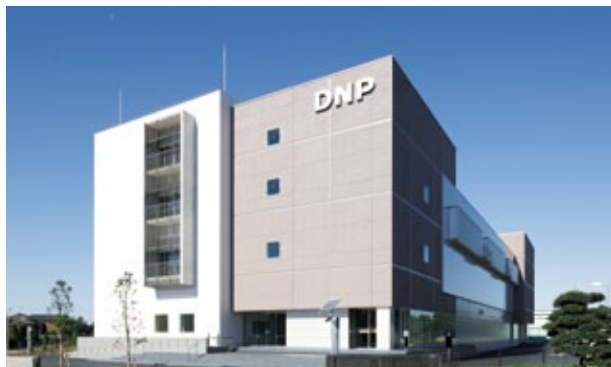
DNP柏データセンター
