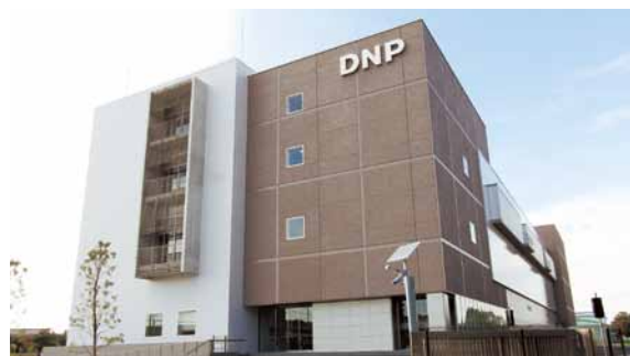
柏データセンター
