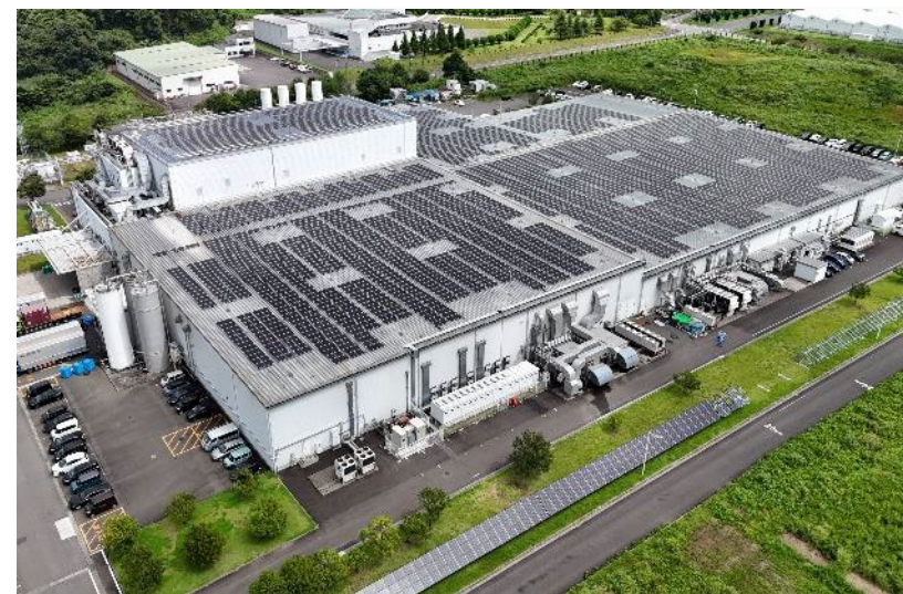
泉崎工場の太陽光発電設備
