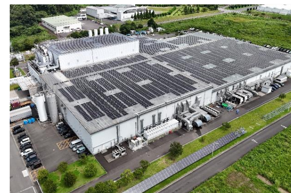
泉崎工場の太陽光発電設備
