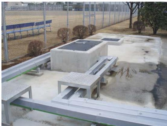
貯蔵タンク更新（二重構造、漏えいセンサ設置）
